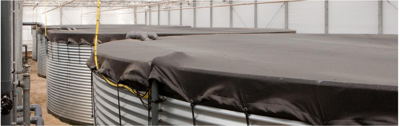
Wenn Wasser in einem unbedeckten Silo gelagert wird, haben Algenwachstum und andere Verunreinigungen meist freien Lauf. Dies führt häufig zu Verstopfungen der Bewässerungssysteme, was unerwünschte Folgen mit sich bringt. Eine Anti-Algen-Abdeckplane verhindert Verunreinigungen und sorgt dafür, dass das Wasser dauerhaft sauber bleibt. Zusätzlich wird das maximale Speichervolumen des Silos genutzt, da die Plane Wellenbewegungen und Verdunstung reduziert.
