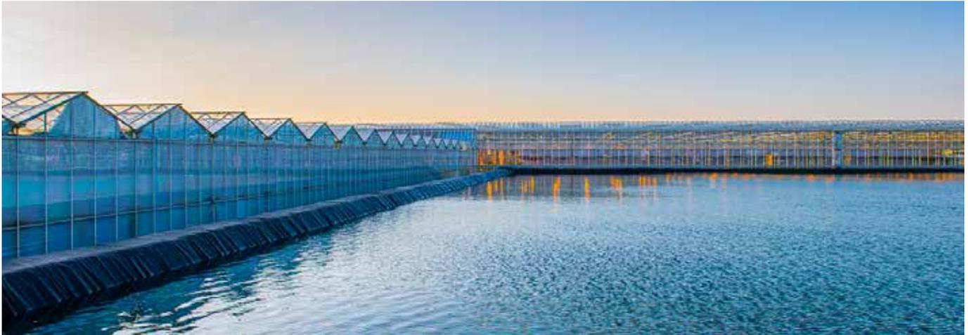
**Für die kontrollierbare Speicherung von sehr großen Wassermengen ist ein gegrabenes und eingedeichtes Wasserbecken gut geeignet. Das Genap-Wasserbecken wurde speziell für die direkte Sammlung von Regenwasser über Pumpensysteme, Gewächshausdächer, Puffertanks und Dachrinnen entwickelt.**
