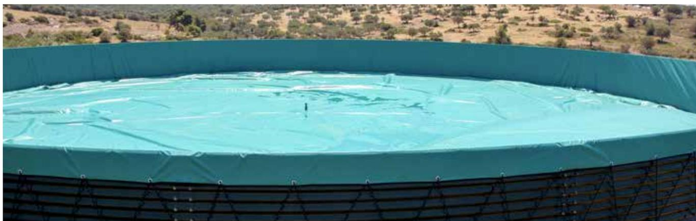
Der GenaFlexstore® ist ein patentiertes, komplett geschlossenes Wasserspeichersystem, bei dem die Siloauskleidung und die Anti-Algen-Schwimmplane zu einem Ganzen kombiniert worden sind. Dadurch ist es fast ausgeschlossen, dass die Wasserqualität von außen beeinträchtigt wird. Da das gespeicherte Wasser kaum verdunstet, kann die Kapazität des Silos voll ausgenutzt werden.
