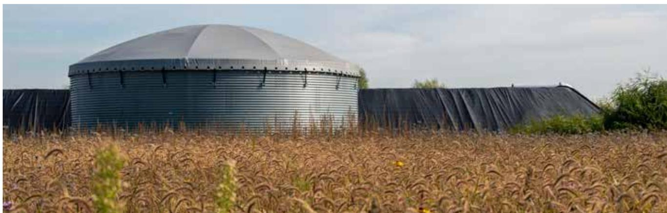
**Der GenaDome ist eine Überdachung, die das Wassersilo vollständig abdeckt und Verdunstung, Algenwachstum und Verunreinigung des gespeicherten Wassers verhindert. Dadurch bleibt die Wasserqualität konstant.**
