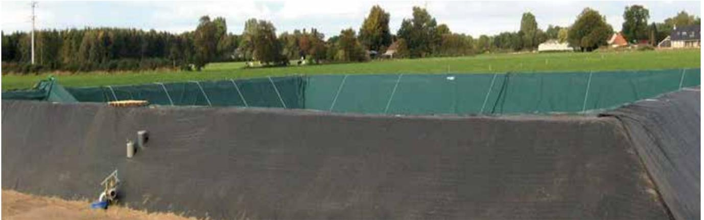
Bei dem Güllebecken von Genap handelt es sich um ein Kiwa-zertifiziertes, in die Erde eingegrabenes Becken für die Lagerung verschiedener Arten von Gülle und Gärresten. Das Becken wird ausgebaggert und mit Folie ausgekleidet. Mit dem Erdaushub werden die Böschungen rund um das Becken angelegt. Sie können ein Güllebecken in jeder Größe bestellen; wir liefern Maßarbeit.
