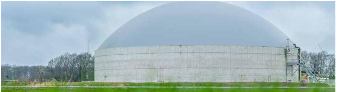
**Biogas ist eine wichtige zukunftssichere Energiequelle und wird u.a. aus organischen Restströmen und Gülle erzeugt. Das Doppelmembrandach von Genap wurde eigens für Biogasanlagen entwickelt und wird auf Gärbehältern, in denen Biogas erzeugt und gelagert wird, eingesetzt.**
