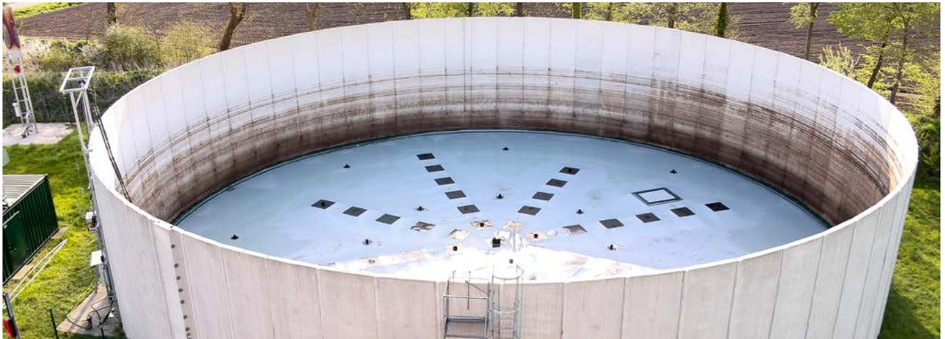
**Das Biogas-Schwimmdach ist eine schwimmende Abdeckung zur Sammlung von Biogas aus Gärresten, die Genap in Zusammenarbeit mit N-E-ST aus Ahaus entwickelt hat.**
