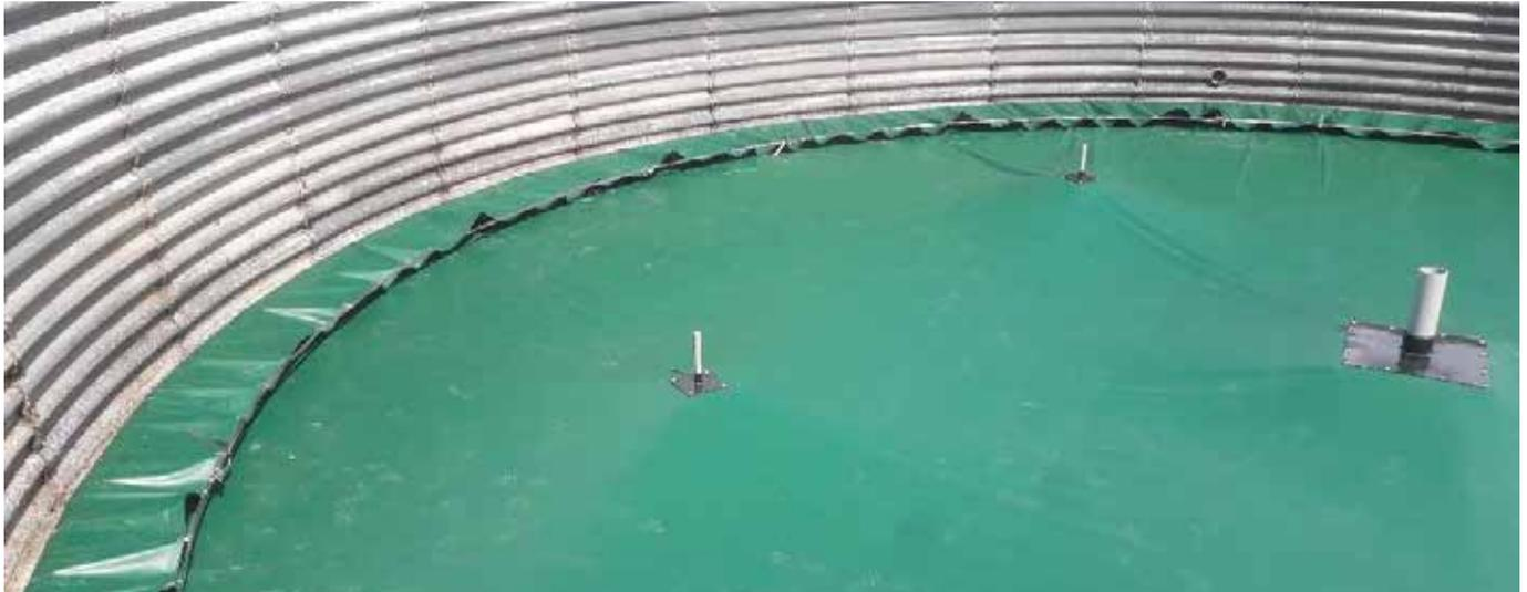
Wenn ein Spanndach, aus statischen Gründen, nicht möglich ist, ist die Schwimmfolie eine sehr gute Alternative. Die maßgeschneiderte Abdeckplane schwimmt auf der Gülle und bewegt sich mit dem Füllstand des Silos. Regenwasser, das sich auf der Abdeckplane sammelt, kann abgepumpt werden; dadurch kann das Lagersystem optimal benutzt werden.
