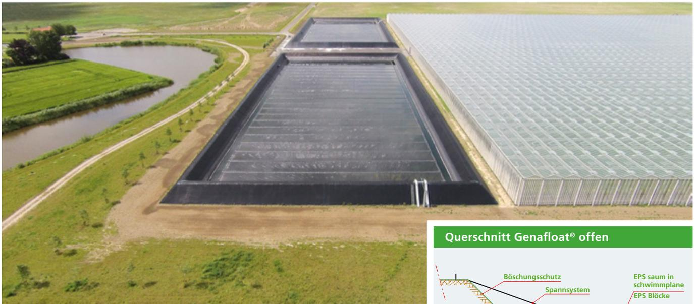
**Genafloat® ist eine robuste schwimmende Abdeckplane für Wasserbecken, die das Algenwachstum verhindert sowie die Verdunstung und den Wellengang reduziert. Dadurch wird die Speicherkapazität des Wasserbeckens maximal ausgenutzt und die Qualität des Wassers bleibt erhalten.**
